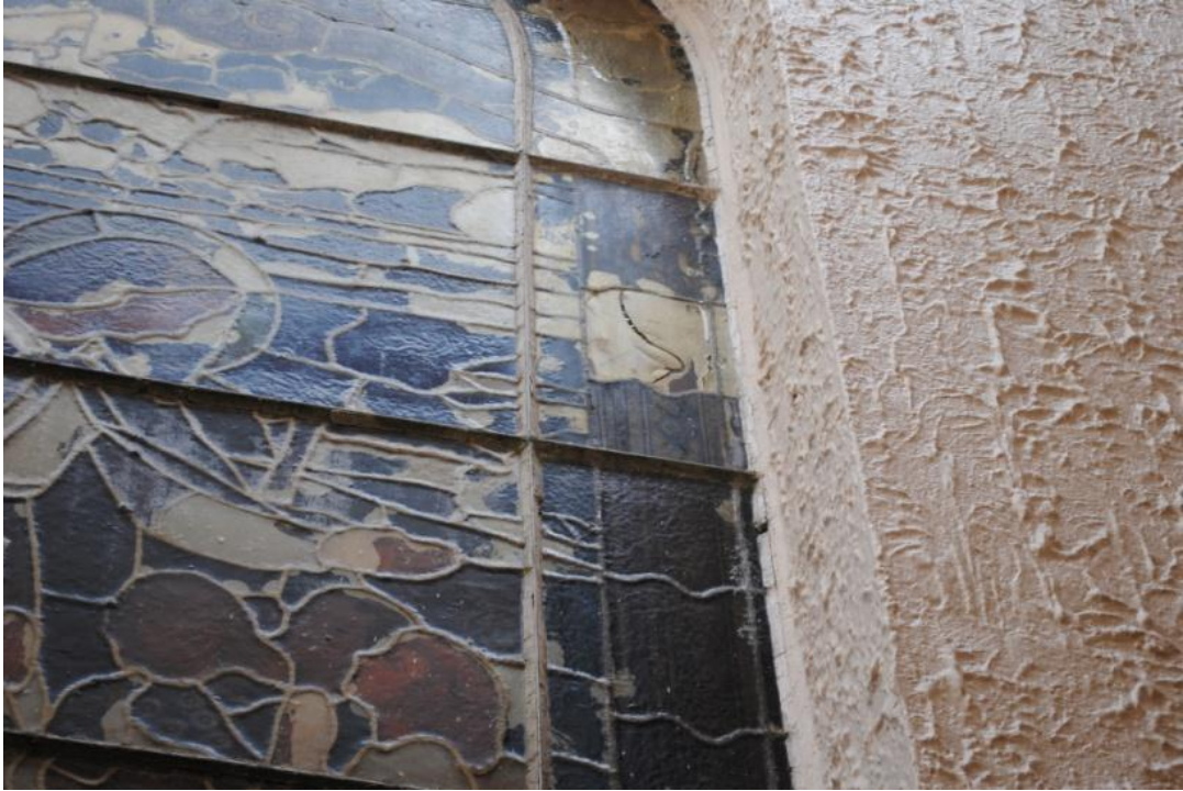
Figura 55 : Reverso da janela com aplicação de polímeros
