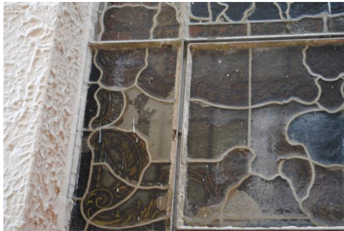
Figura 54: janela com aplicação de polímero
