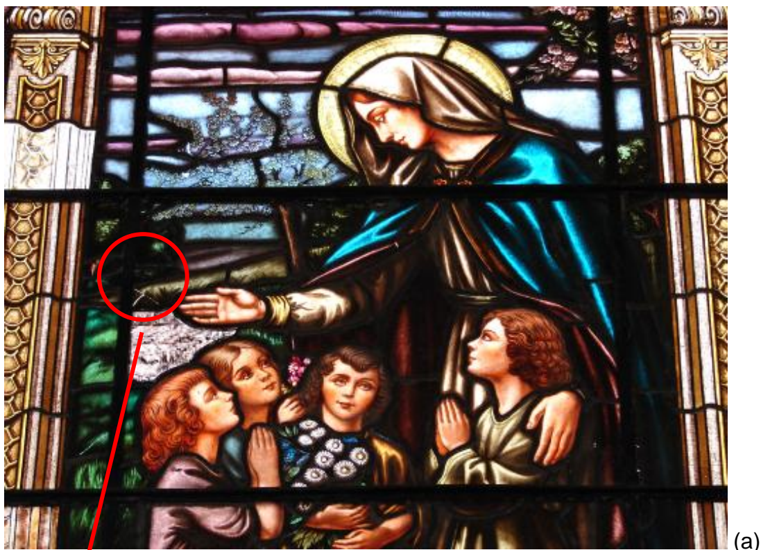
Figura 43: fraturas do tipo instável (a)
