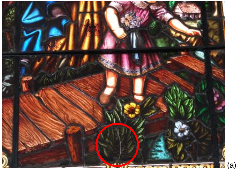
Figura 42: fraturas do tipo estável (a) Detalhe (b)
